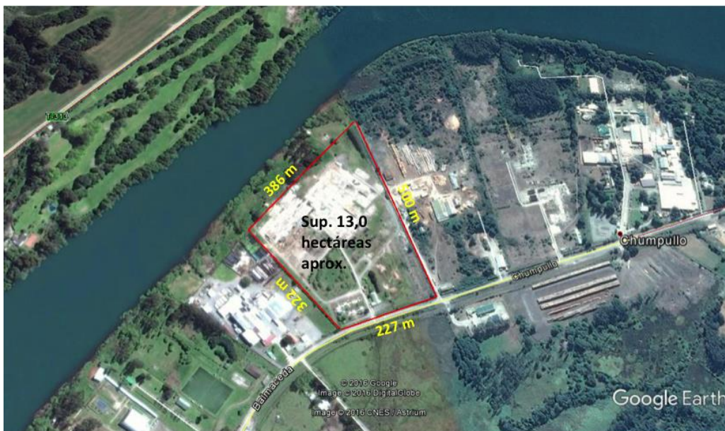
Imagen Nº 23. Terreno Nº 2 (ex Masisa). Inversionistas Privados
